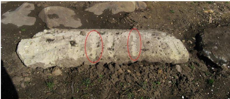
Пример механичког оштећења на камену, узрокованог пољопривредном машином.
