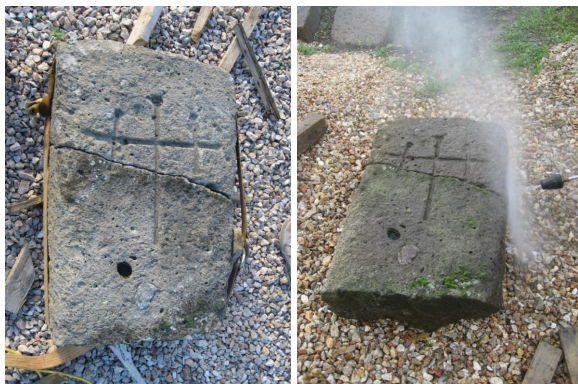
Фиксирање и лепљење. Чишћење споменика.
