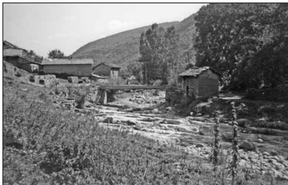
Слика 4. Бетонски мост преко Дојкиначке реке, Брлог, 2000. године
