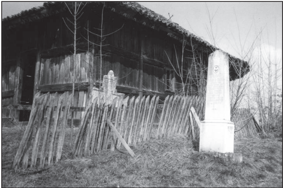
Црква брвнара у Мрсању, сиволашњи изглед – западна и јужна страна, фотографија Ирена Гвозденовић, 1996. године.
